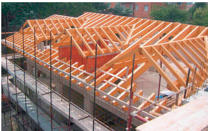
Herstellung von Dachkonstruktionen direkt aus dem CAD/CAM
