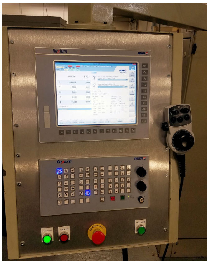
Nach dem Retrofit
