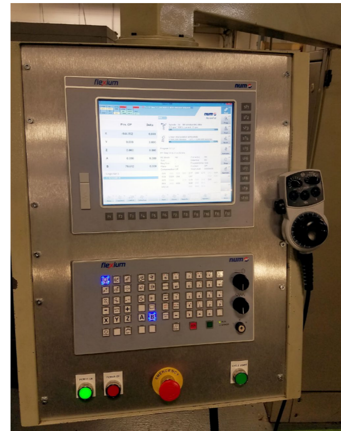
Après la modernisation
