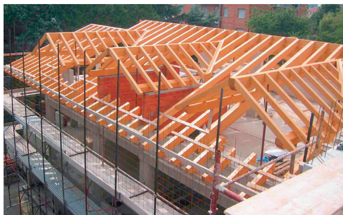
Produzione di strutture per tetti direttamente da CAD/CAM
