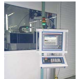
Poste de commande de la machine
