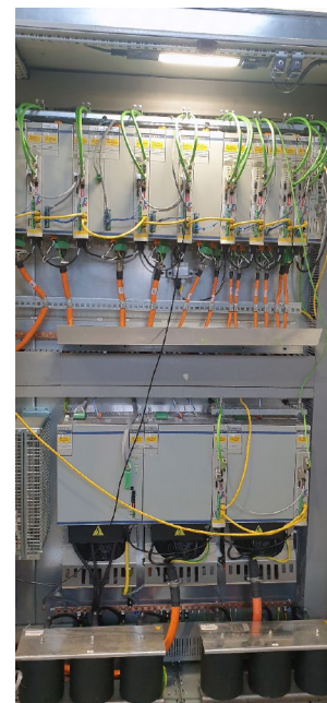
Montageplatte mit MDLUX-Antrieben
