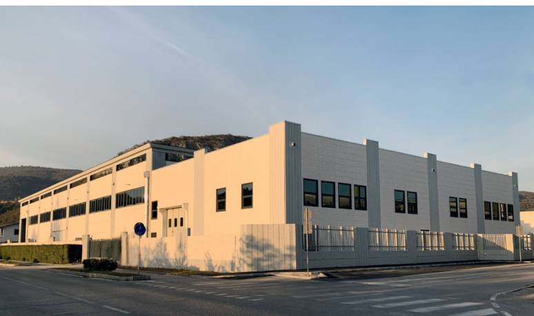
Quartier generale di Prevalle, in provincia di Brescia, di Meccanica Ponte Chiese
