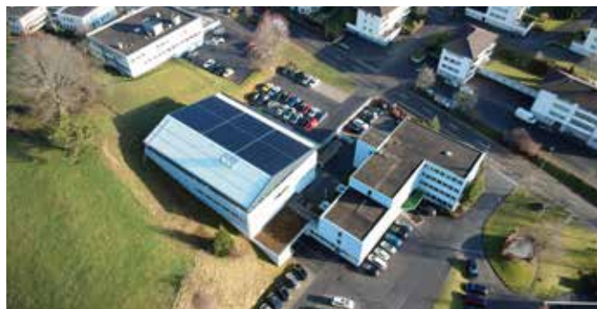
位於圖芬廠房屋頂的太陽能光電系統
