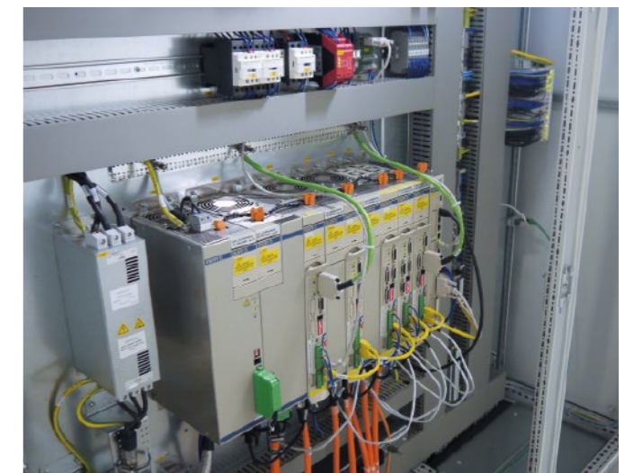
控制柜详细视图：Flexium+ 68 CNC 系统，配备集成了安全解决方案的 NUMDrive X。
