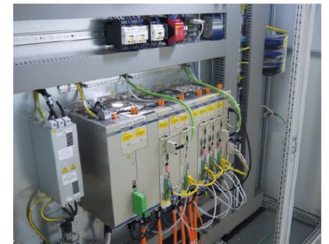
Detailansicht Schaltschrank: Flexium<sup>+</sup> 68 CNC-System mit NUMDrive X mit integrierter Safety-Lösung.
