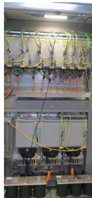
带 MDLUX 驱动器的电子控制面板工作中心
