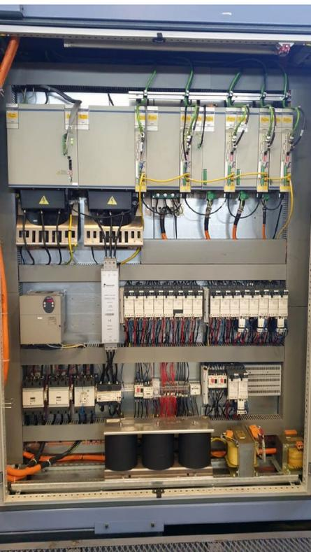
Armoire électrique avec alimentation MDLL et variateurs MDLUX
